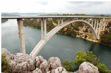
22. kép: Az elkészült Krka-híd
