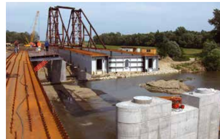
24. kép: Az épülő Mura-híd a Budapest–Zágráb autópályán
