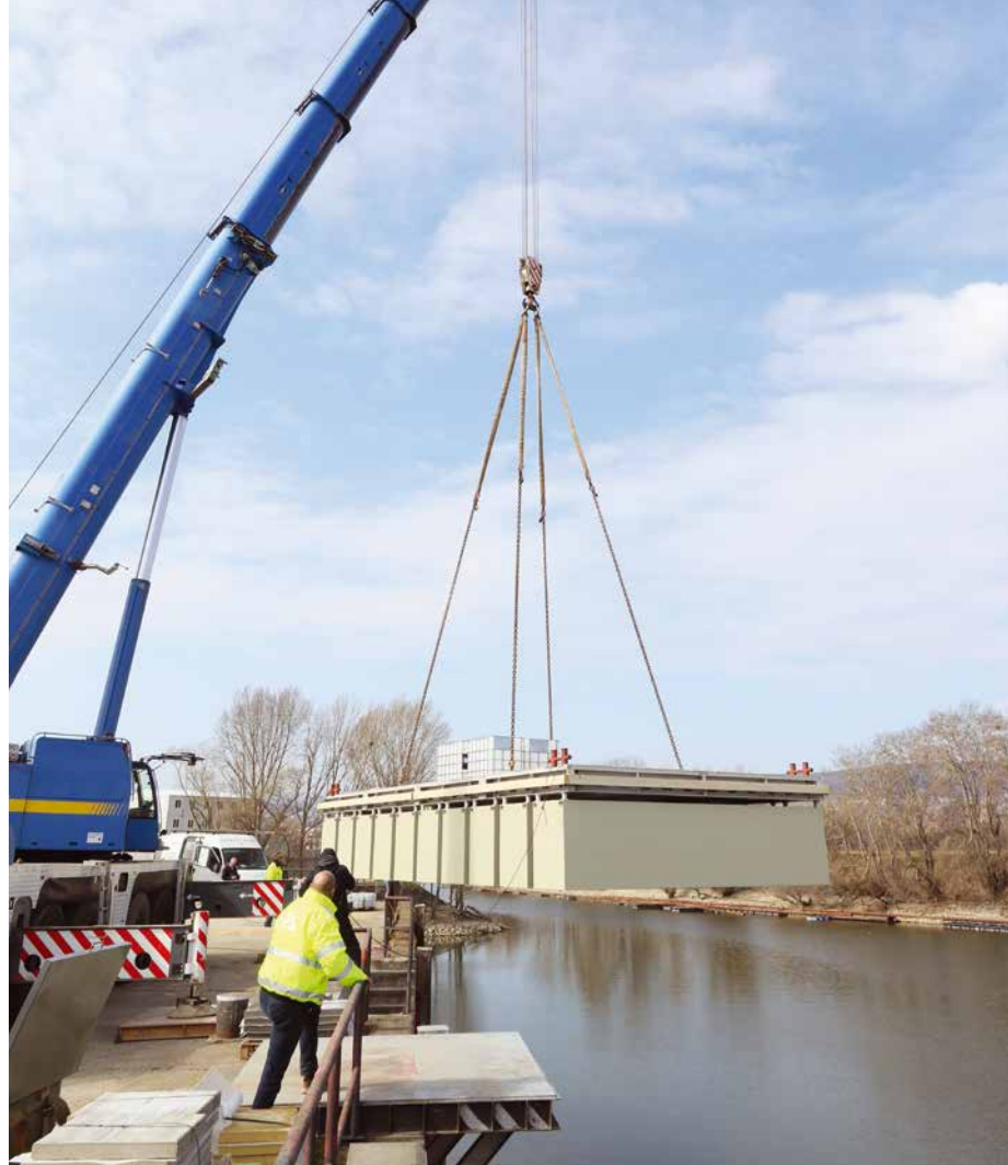
Úszómű vízre helyezése
