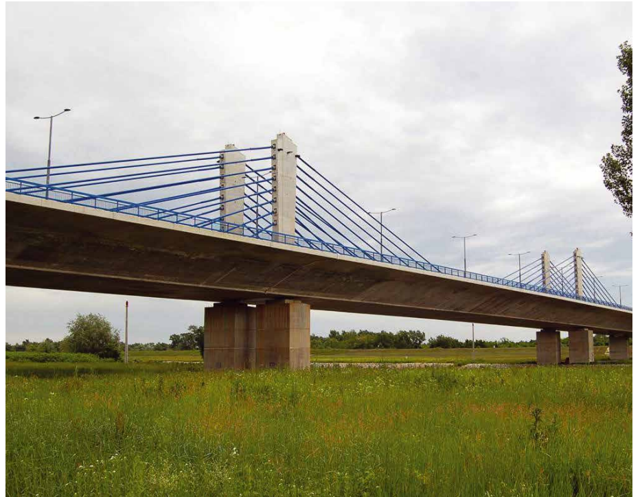
18. kép: A végül megépült Domovinski most Horvátország első és egyetlen extradosed hídja
