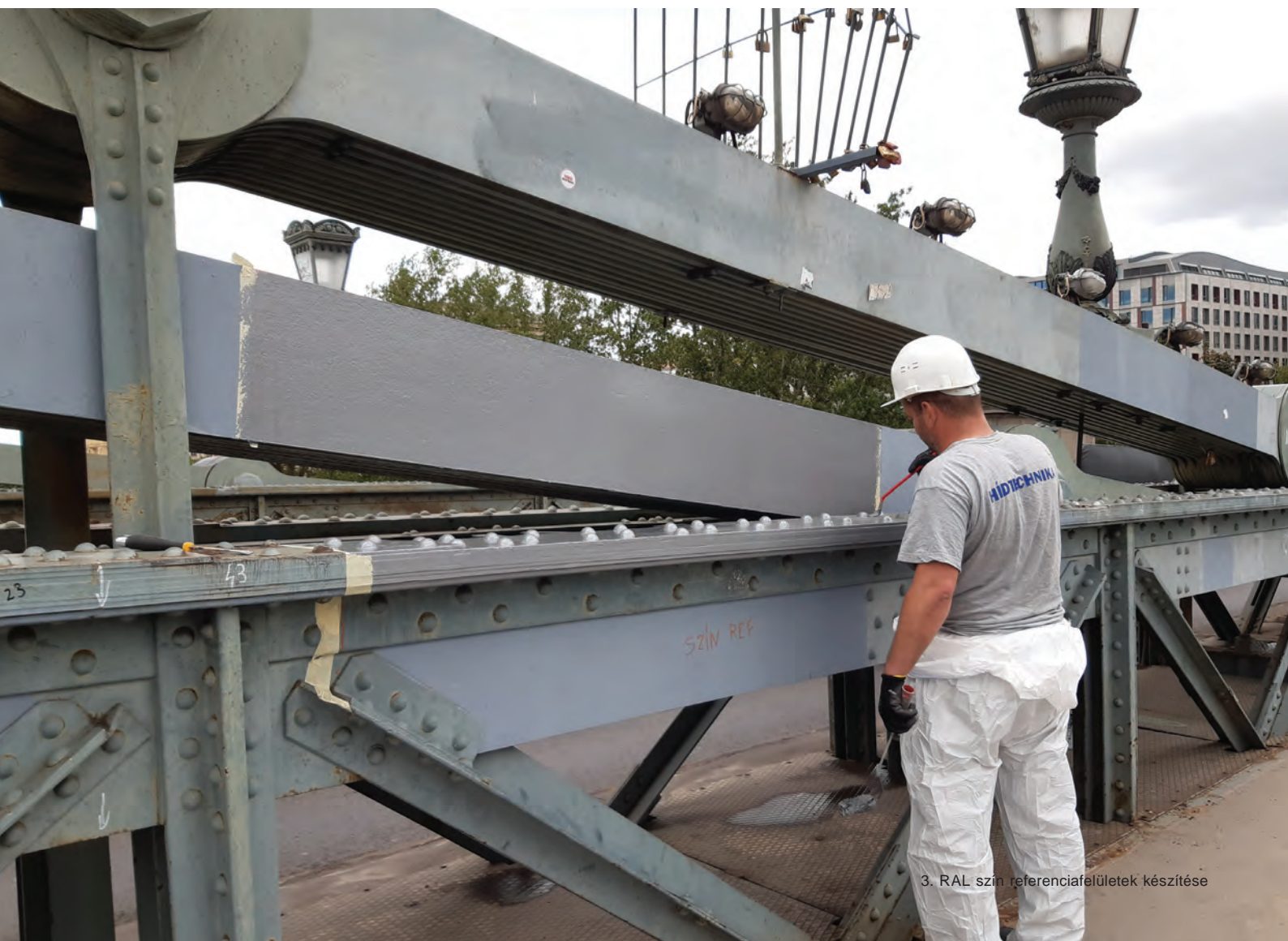
2. Szétbontott mintalemezek vizsgálata
