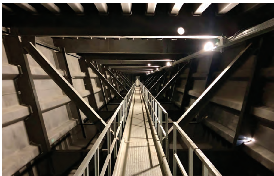
Feladatunk volt a híd belső világításának kiépítése
