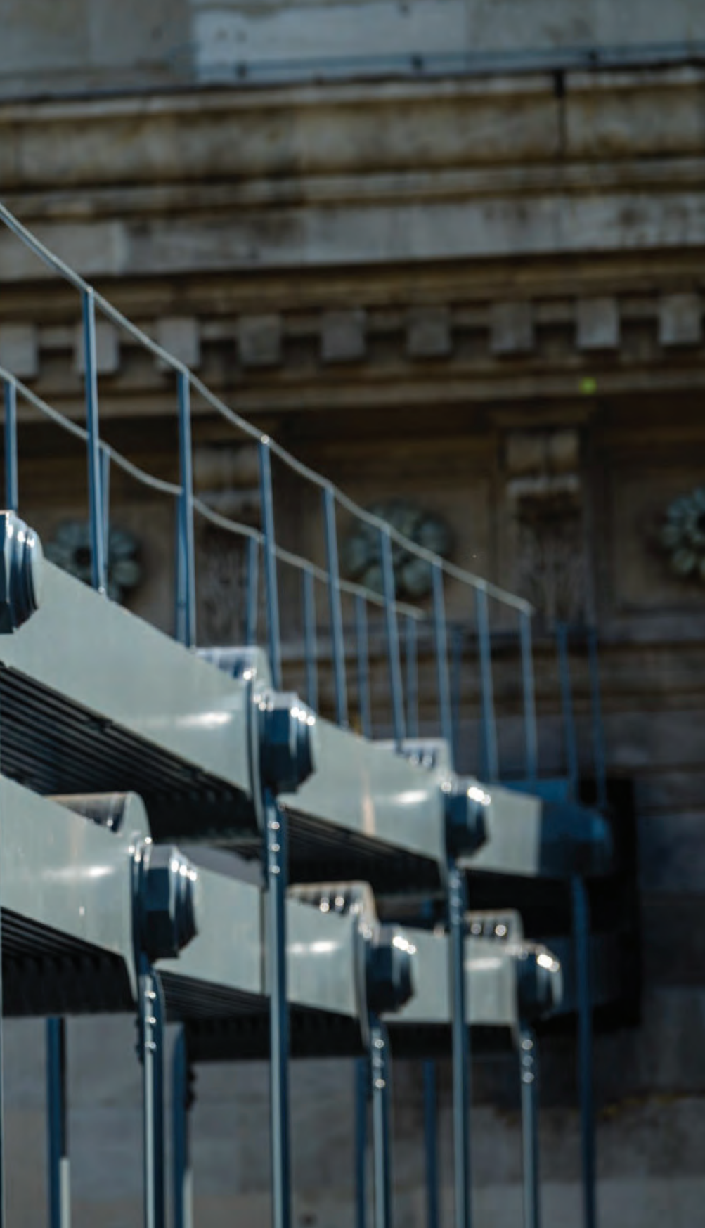
7. Láncszakasz az elkészült korrózióvédelemmel
