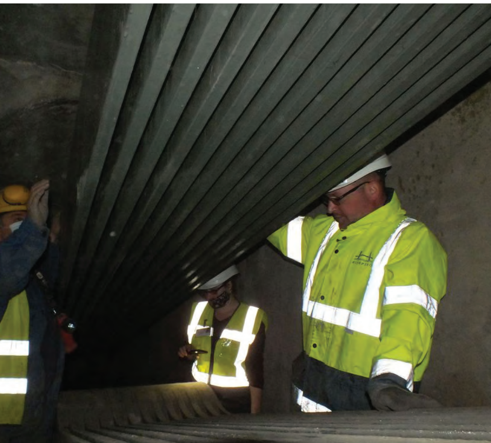
8. Láncsatorna felső szakasz
