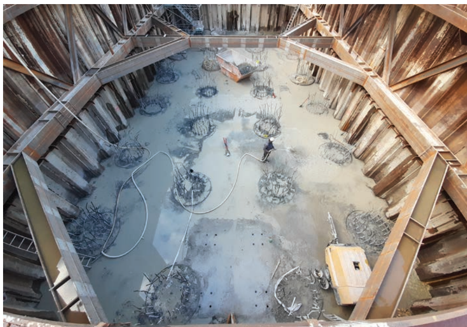
Visszavésétt cölöpfejek 6. j. pillérenél
