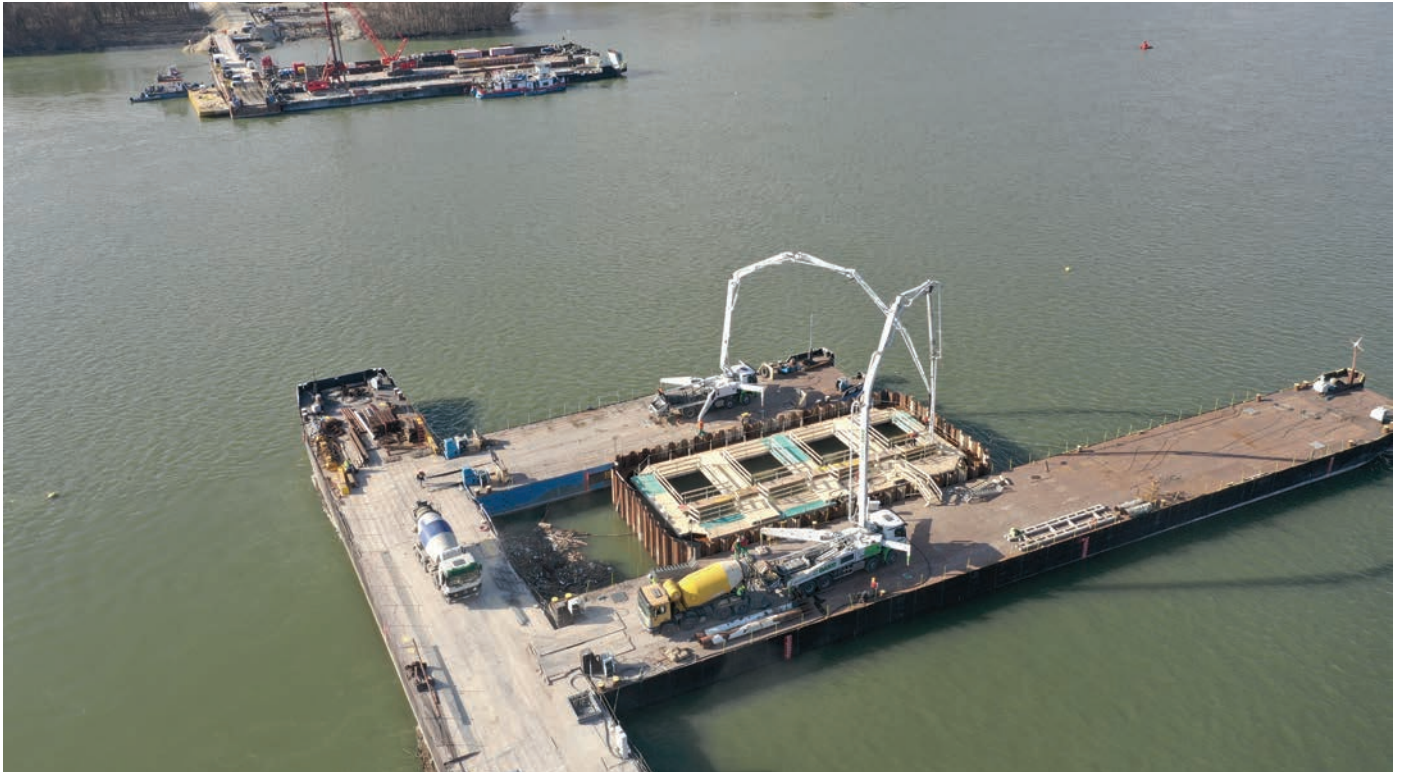
Vízalatti betonozás 5. j pillérnél nappal (II.) (Kispéter Z.)
