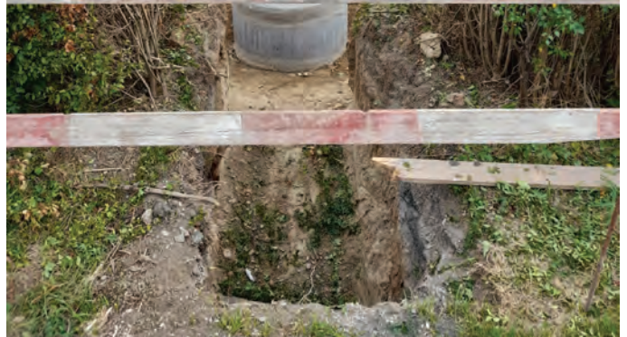
7. kép: SZ 1-0-0 szakasz 9. j. akna építés közben
