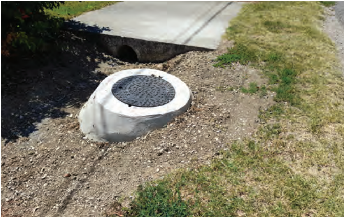
3. kép: Rekonstrukció során felújított tisztítóakna
