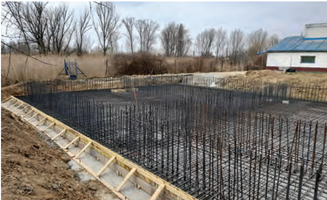
4. kép: Új kombinált biológiai tisztító műtárgy alaplemezeinek vasszerelése
