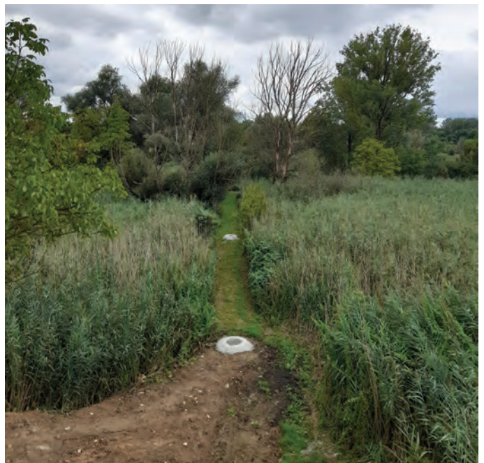
8. kép: A tisztított szennyvízvezeték aknáí
