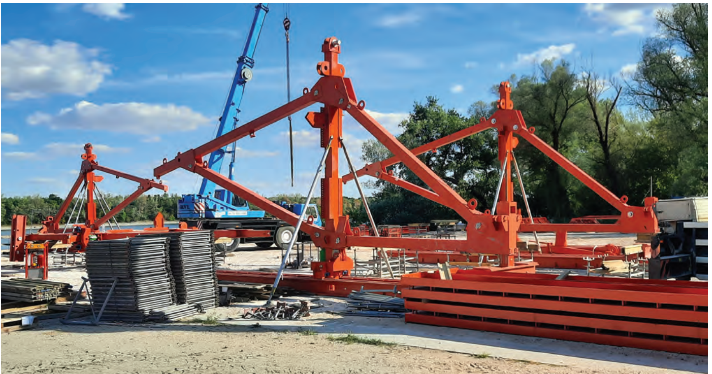
1. kép: Zsaluzókocsi felső egység acélsín és főkeret szerelési munkái
