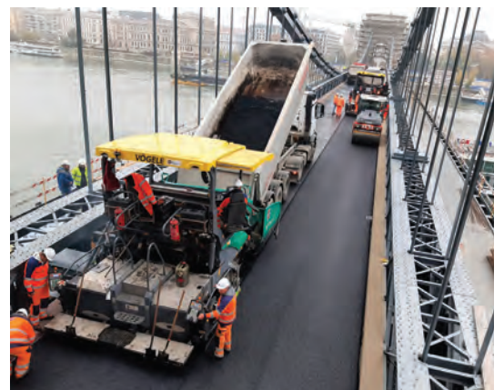
Kopóréteg készítése
