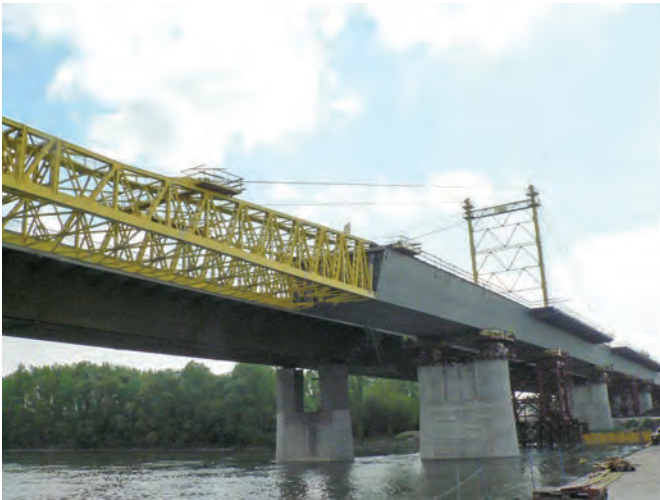
4. ábra: a) Szekrény keresztmetszetû híd betöltése (M0 autótút Deák Ferenc híd), b) erősítõ keresztborðák kialakítása
