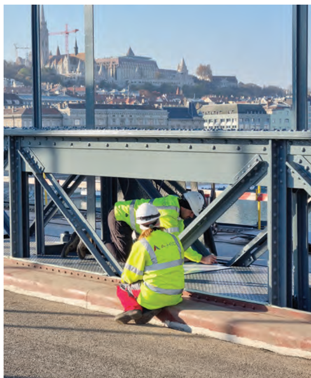
Bordás lemezek felmérése és beépítése
