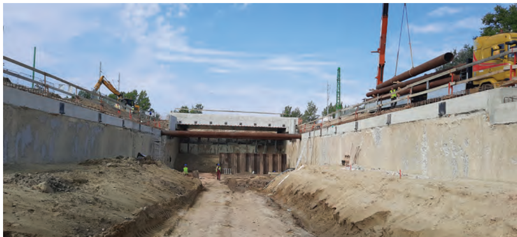
2. kép: Csődúcok elhelyezése sárberki oldal (fotó: Varga Zoltán A-Híd Zrt.)
