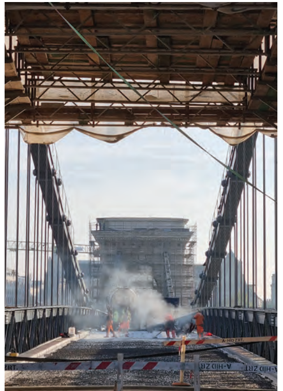
Öntött aszfalt védelem készítése
