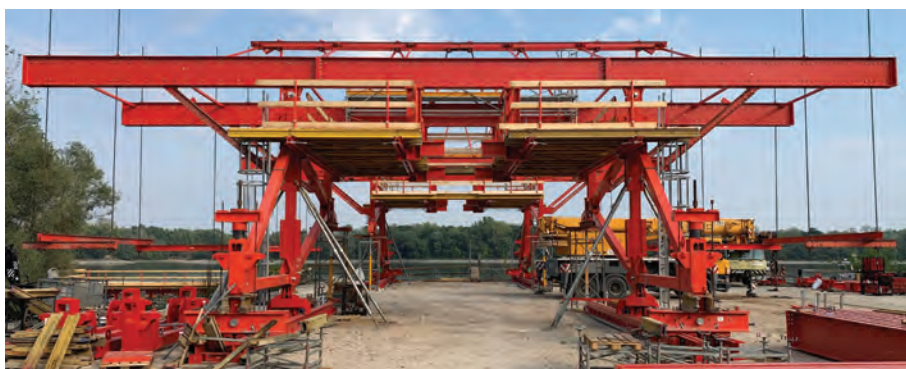
4. kép: Zsaluzókocsi felső rész előszerelt állapotában
