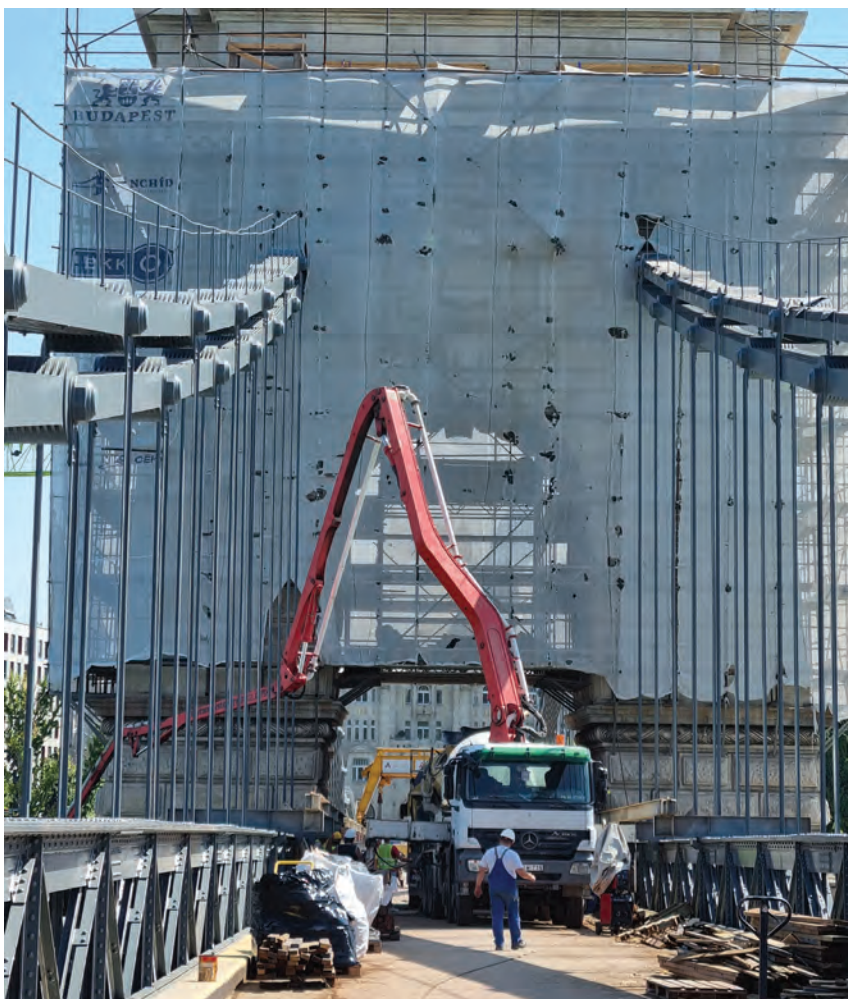
Pillér körüli vasbeton járda betonozása
