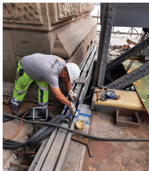
Dilatáció helyszíni illesztése
