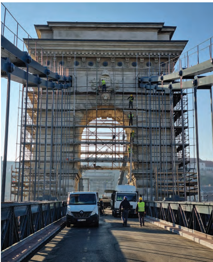
Pesti pilon állványbontás
