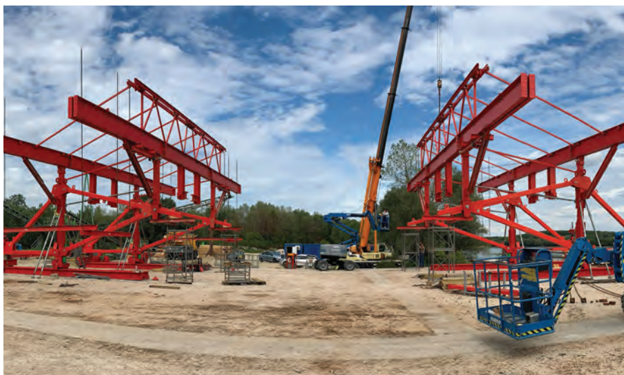
3. kép: Zsaluzókocsi felső rész előszerelés közben
