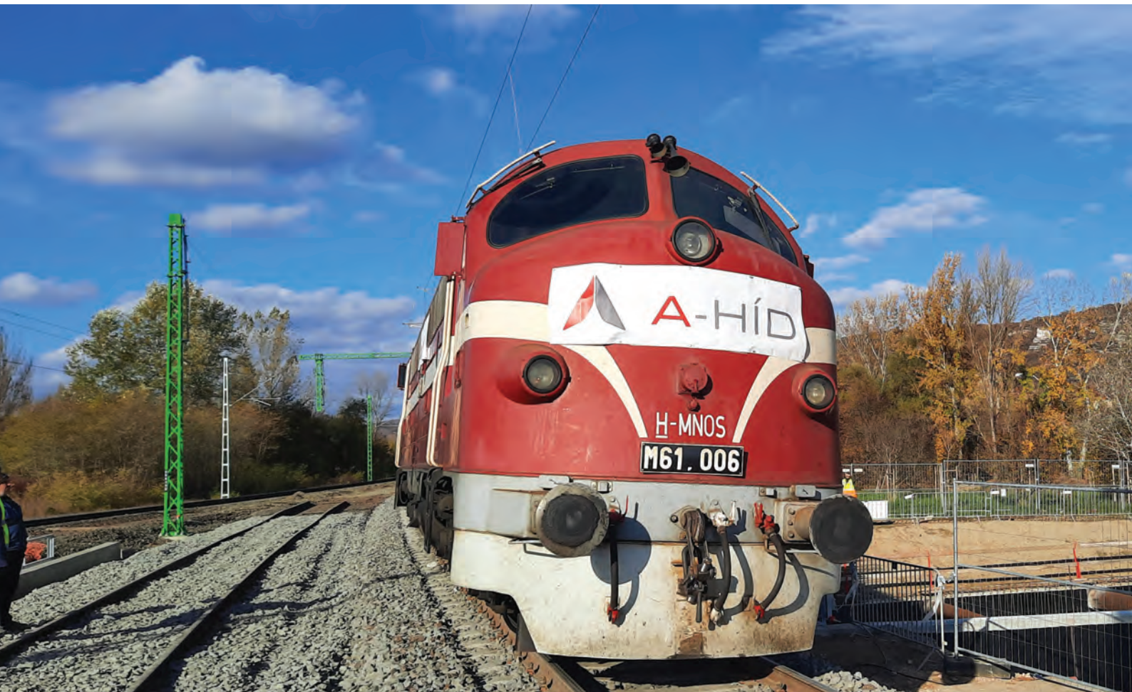
1. kép: Vasúti híd jobb vágányának próbaterhelése (fotó: Varga Zoltán, A-Híd Zrt.)
