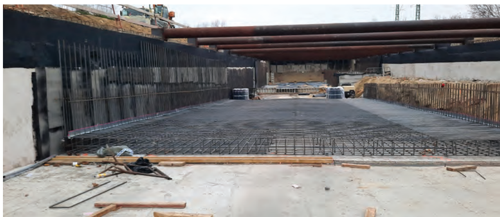
3. kép: Aluljáró „G” dilatáció alaplemez vasalás sárberki oldal (fotó: Varga Zoltán, A-Híd Zrt.)
