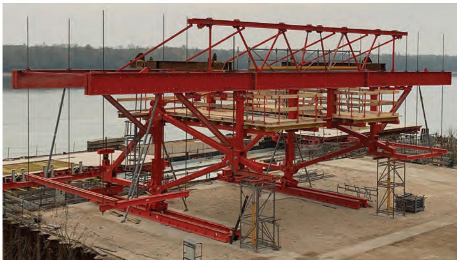
6. kép: Ercsi, előszerelt, emelésre előkészített zsaluzókocsi felső rész, munkaszintekkel
