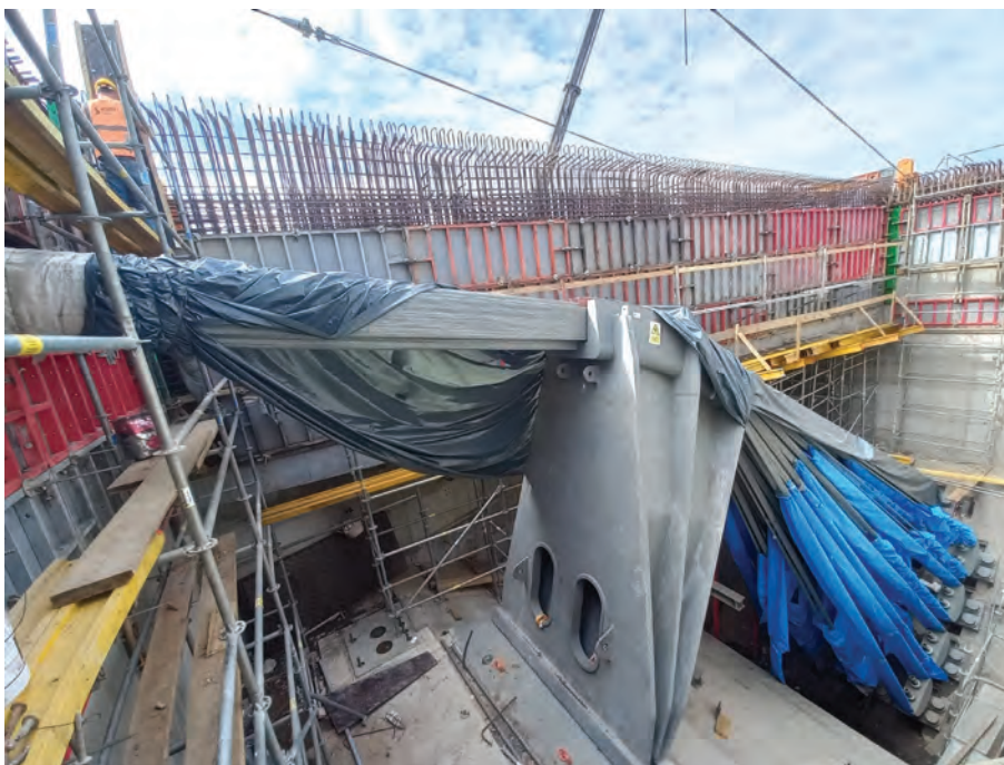
Brăilai függőhíd kábelek lehorgonyzása
