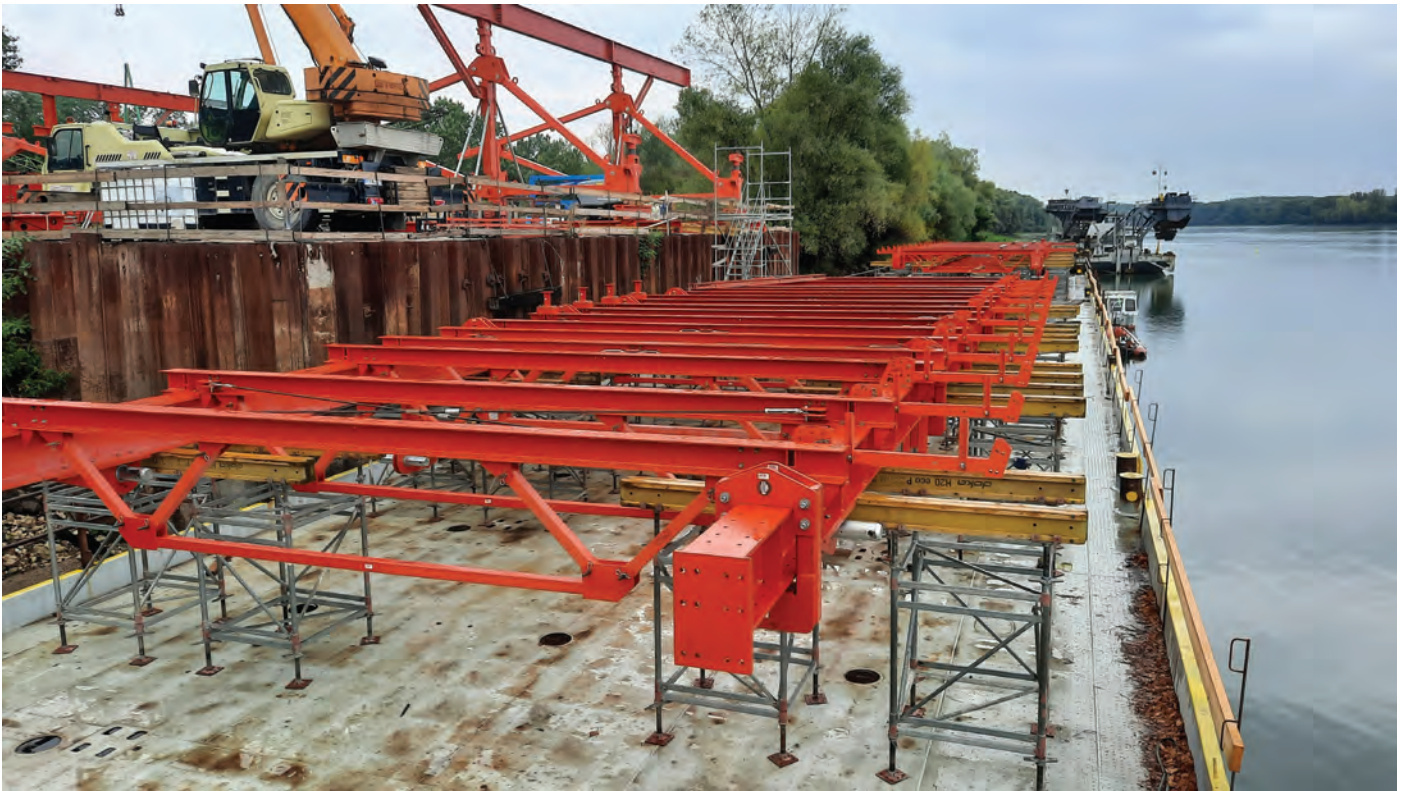
5. kép: Zsaluzókocsi alsó platform szerelés közben, „RORO” bárkán, ID állványokon
