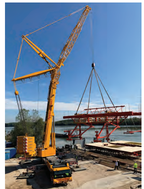
7. kép: Zsaluzókocsi felső egység bárkára való beemelése 450 tonnás daruval, Ercsi
