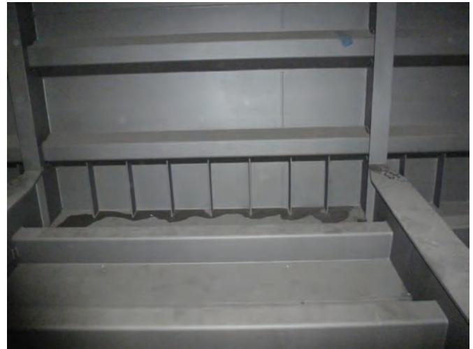
4. ábra: a) Szekrény keresztmetszetû híd betöltése (M0 autótút Deák Ferenc híd), b) erősítõ keresztborðák kialakítása
