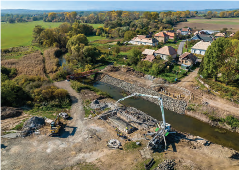
Cölöpösszefogó betonozása madártávlatból (Főmterv fotó)
