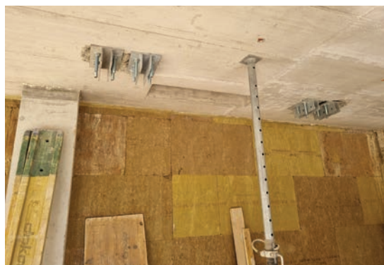
10. kép - HEB400 tartók lehorgonyozása földémsík alatt 1.
