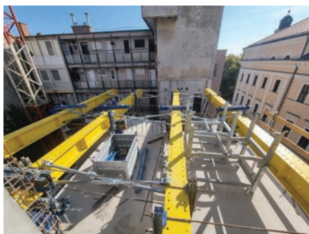
9. kép - HEB400 tartók és merevítései a 2. emelet feletti földemen
