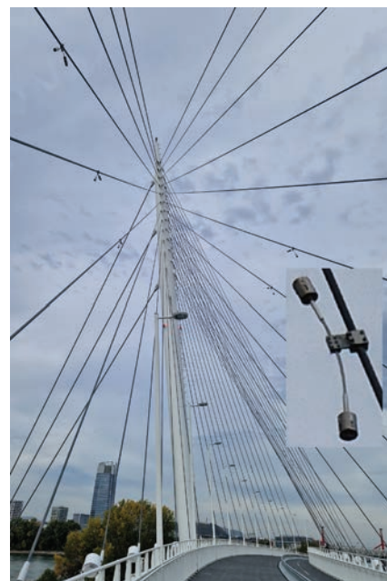
4. ábra: Legyártott és összeszerelt, beépítésre kész csillapítóelem.
