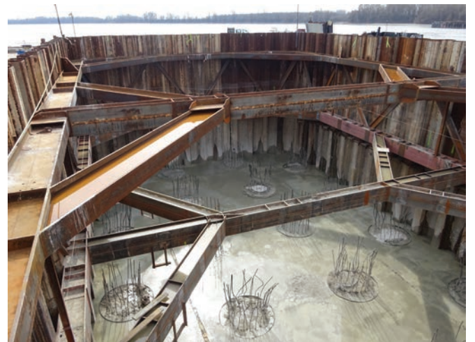
Visszavésett cölöpök a frissen elkészült cölöpösszefogóval
