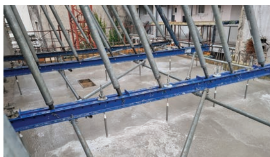
12. kép - Függesztőrendszer és elkészült vasbeton lemez
