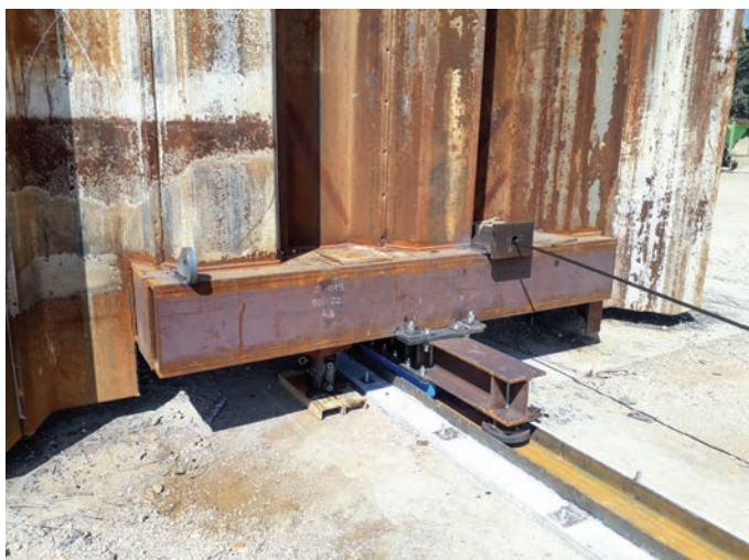
Kéregelem alatti kihúzópálya és a forgóváz kialakítású görgős kocskák
