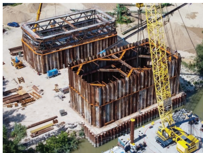
Kéregelem és őrfal gyártótéri összeállítása (parttól távolabb) és emelése (parthoz közelebb)
