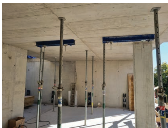
11. kép - HEB400 tartók lehorgonyozása földémsík alatt 2.
