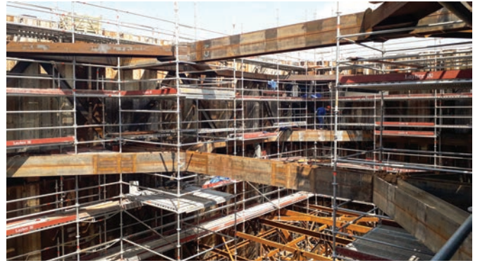
Itt már erejüket megfeszítve dolgoztak a kivitelezők az összeállításon
