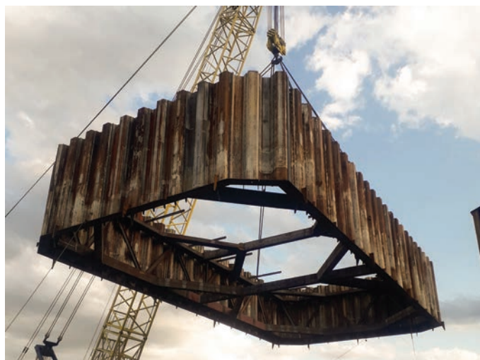
Felső őrfal elem emelése gyártótérről a bárkára
