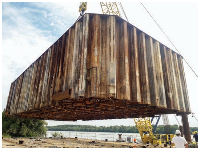
Alsó kéregelem emelése a gyártótéren
