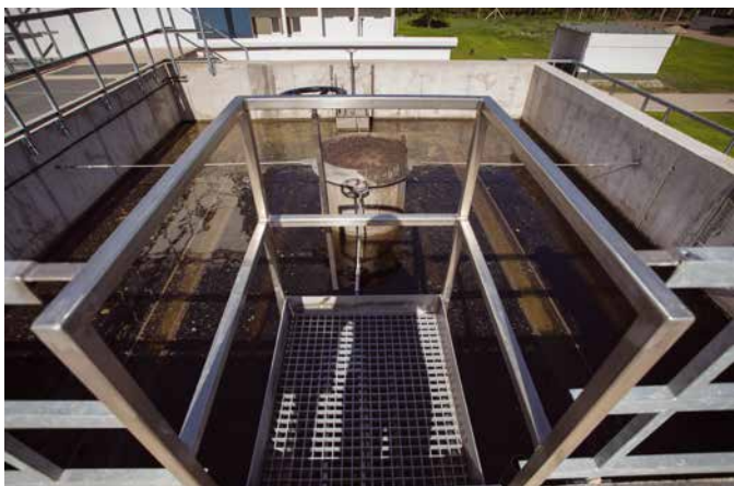
Kombinált műtárgy utóülepítő medencéjének tolézár kezelő pódiuma
