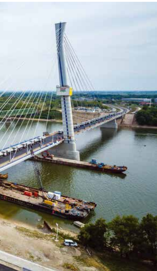
A komáromi híd a nemrég lezajlott próbaterhelés alatt
