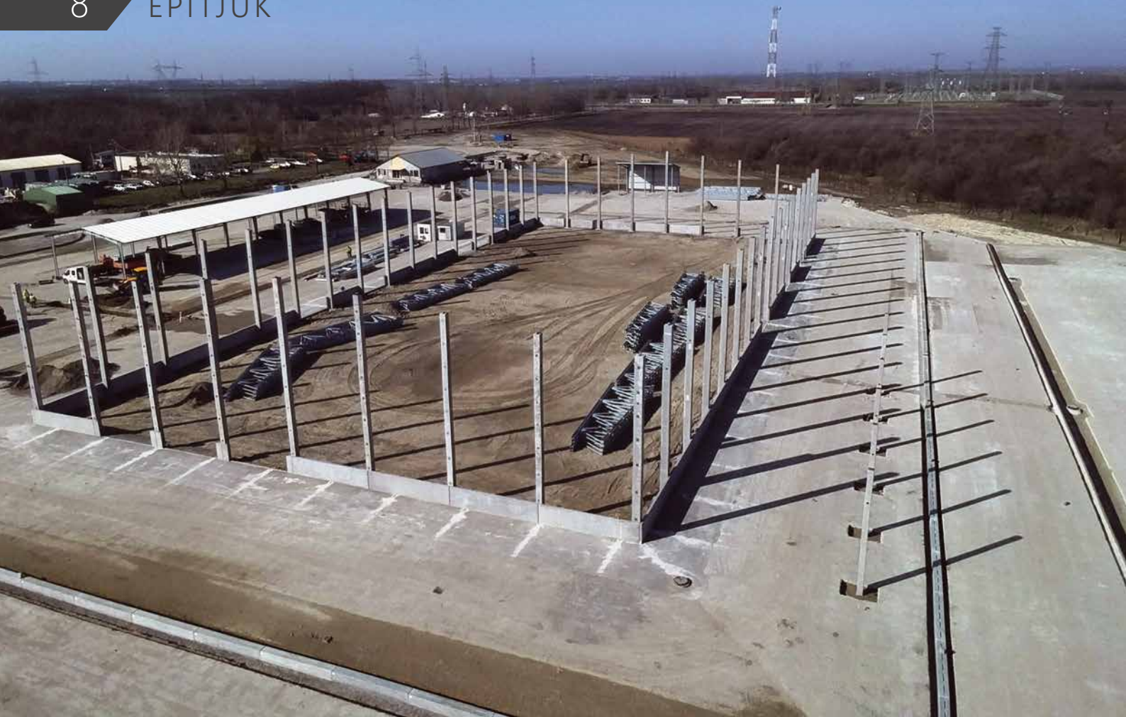
5. Csarnoképítés, vízelvezetés
