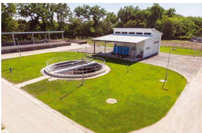
Átalakított iszapsűrítő műtárgy és újonnan épült gépkocsitároló szín
