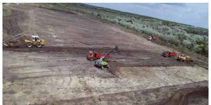
10. Kezdődik a lerakó bővítése
