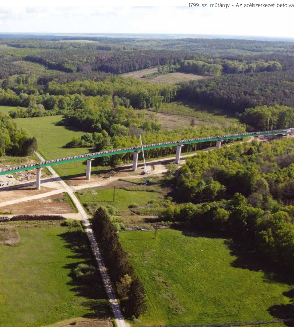
1799. sz. műtárgy - Az acélszerkezet betolva
