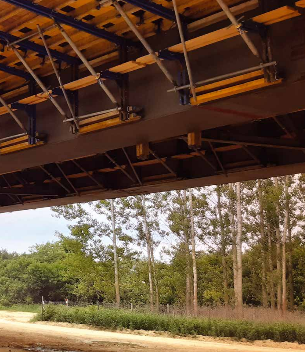
1682. sz. műtárgy - Elkészült pályalemez
