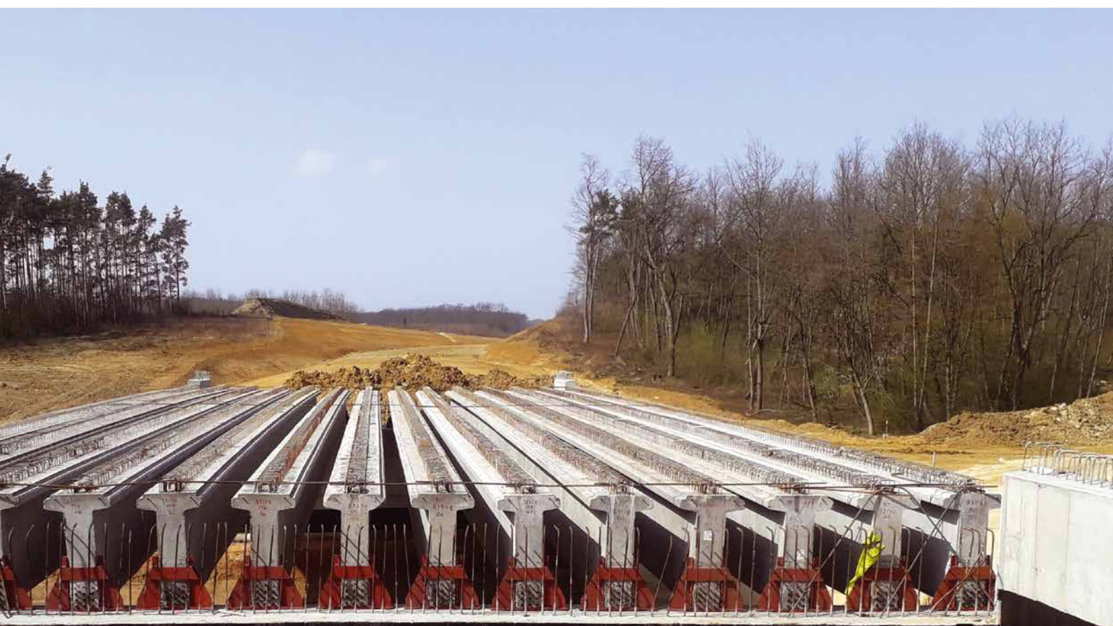
1778. sz. műtárgy - Az elhelyezett FPT gerendák a kitámasztó elemekkel
