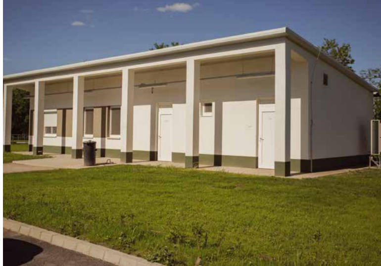
Kezelőépület és a belső hőmérsékletért felelős hőszivattyú külső egysége
