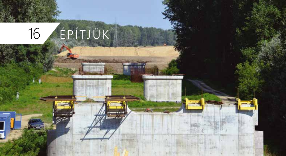
A távolban megkezdődött a H8 hídfő földmunkája
