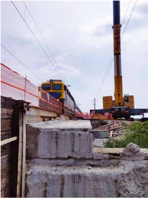
Felszerkezet bontása és kiemelése
