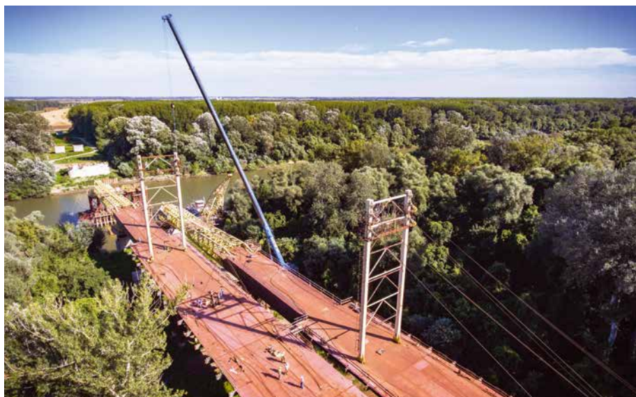
Árbócok a hídpályán feszítési munkák közben
