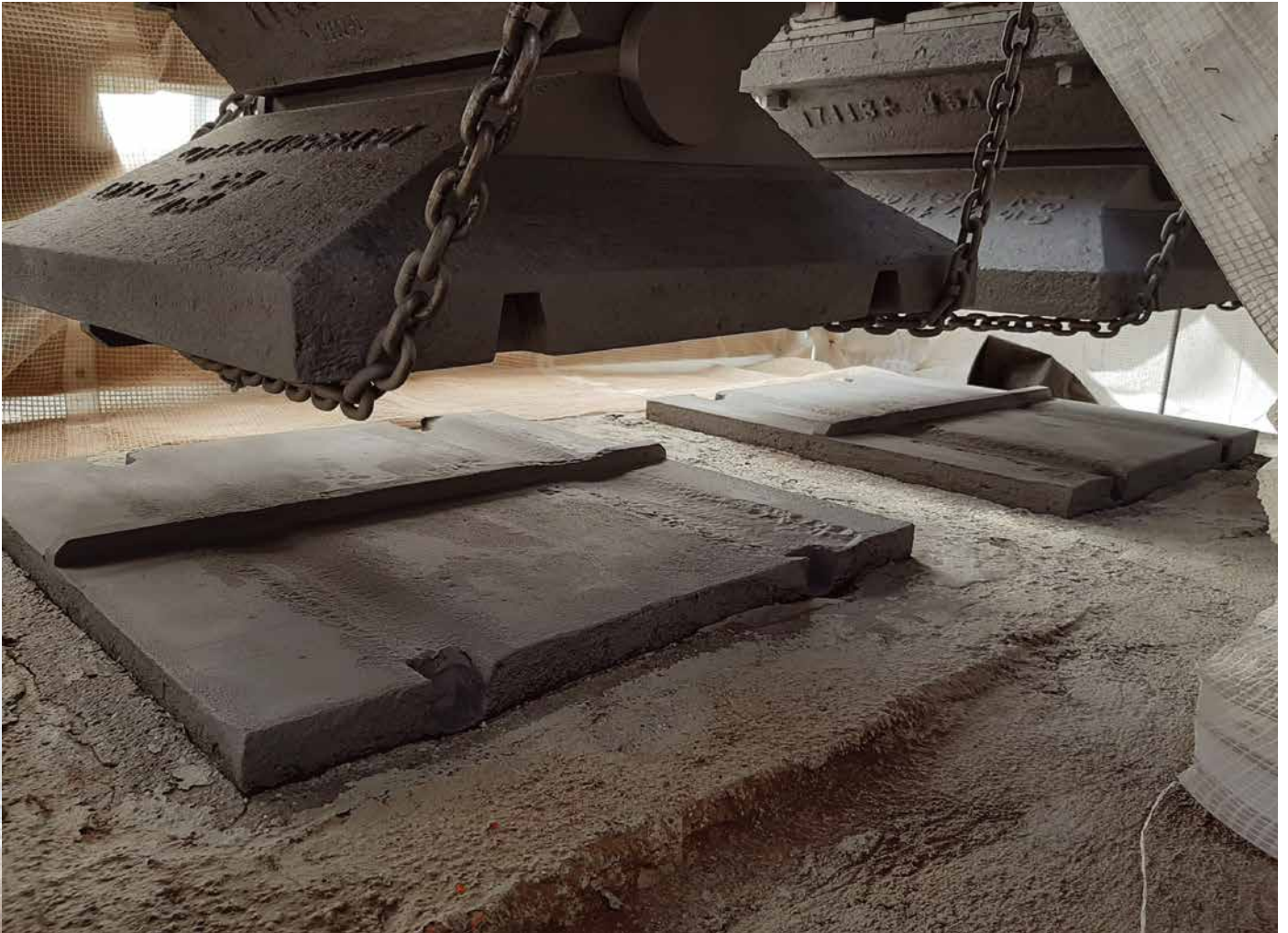
Felvétel a kiemelt saru alatti állapotokról
