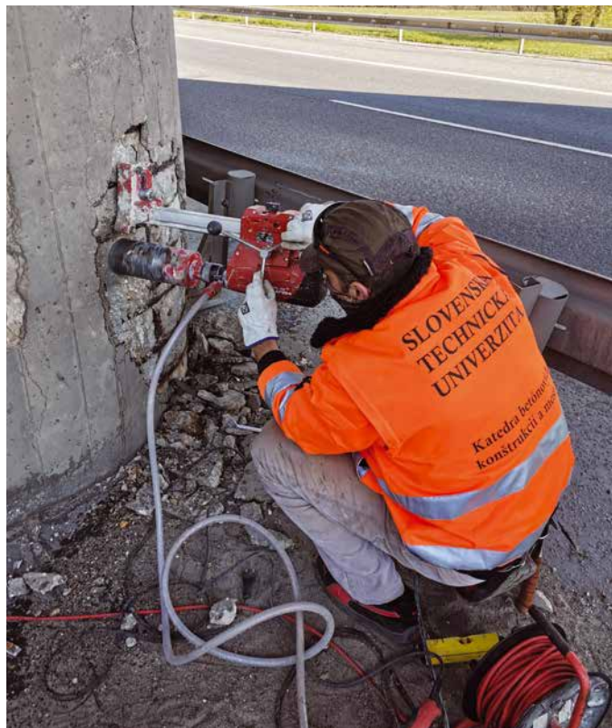
23. kép: Pillér-diagnosztika közben
