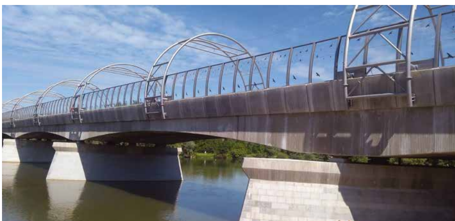
7. kép: A trencséni új vasút híd – az egész alépítményt én terveztem
