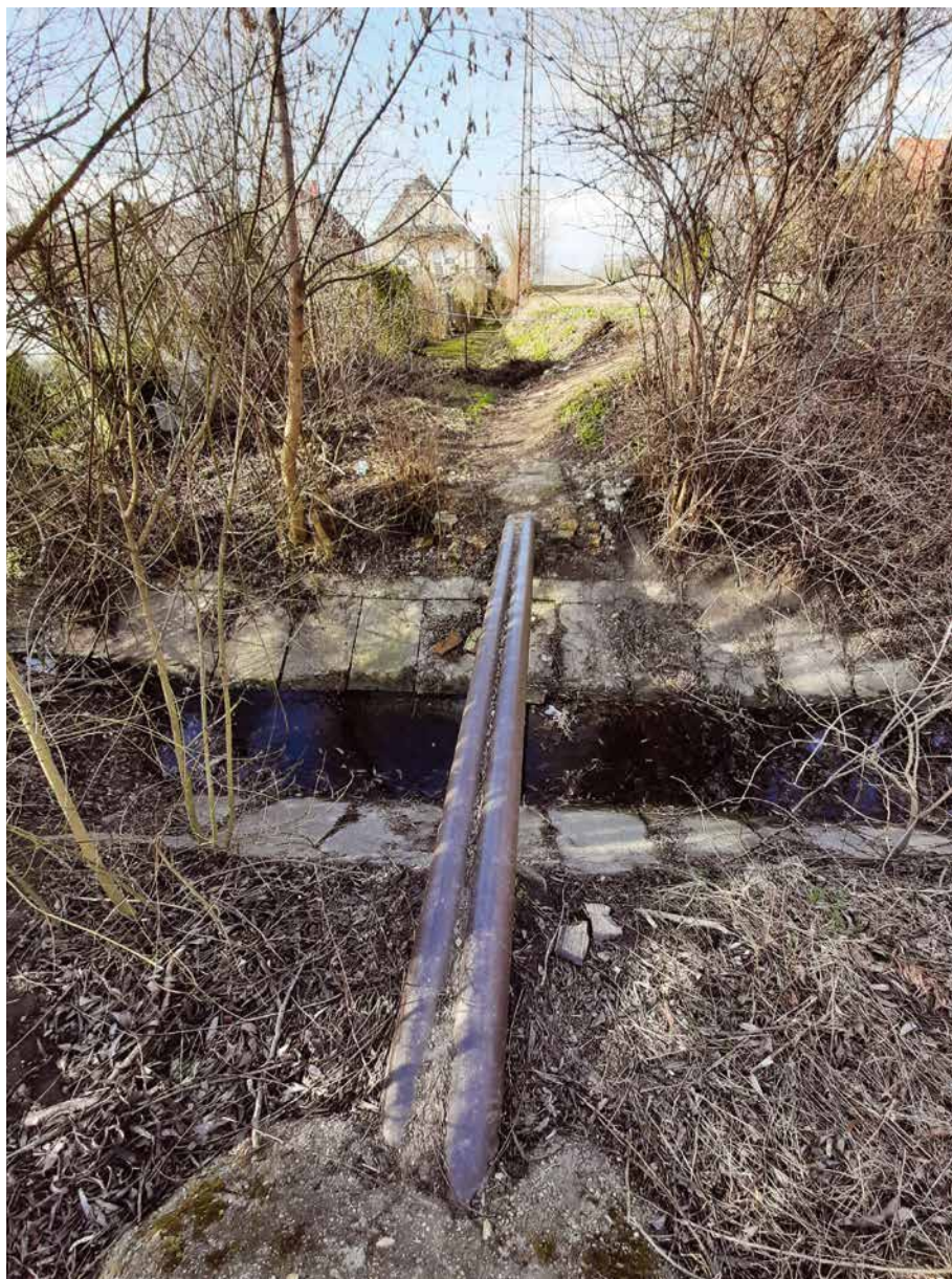
5. kép: A Dubnik patak keresztezése, az építendő keretműtárgy helye
