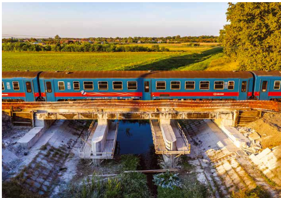
Tápiógyörgye, Tápió-patak híd elbontott felszerkezet
