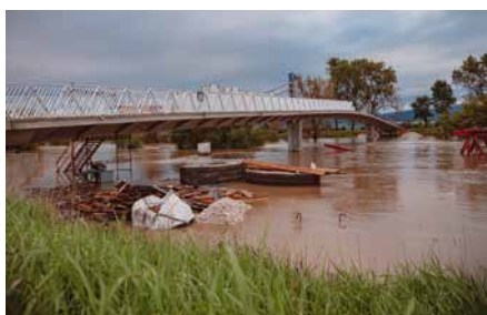
21. kép: A nagytapolcsányi gyalogos hidam építése árvíz közben
