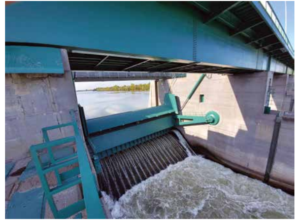
Dunakiliti duzzasztómű felújított VI-os szegmensnyílás
