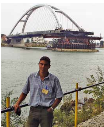
1. kép: Az Apollo híd építésénél
