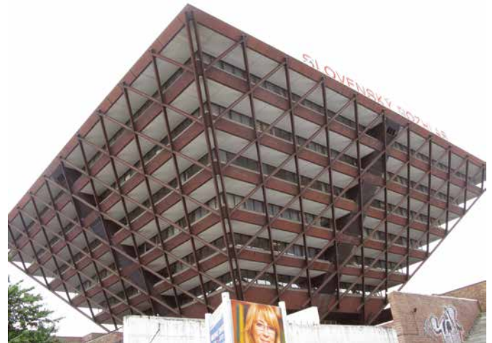
3. kép: A pozsonyi rádió épülete
