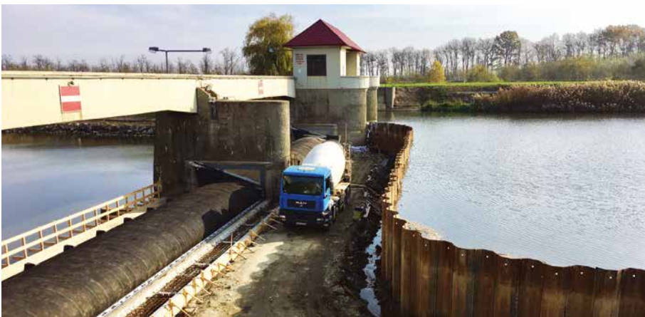
Reggeli készülődés ideiglenes elzárószervezet gerendájának betonozásához- szádolás mentett oldalán
