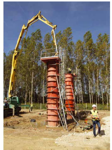
Csencsi-híd, pillér-betonozás
