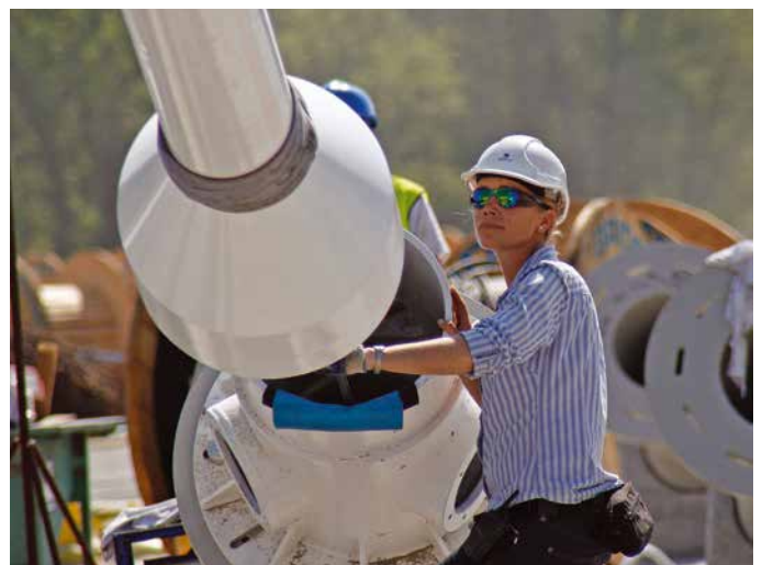
22. kép: Kábelbefűzés valahol a nagyvilágban „Szerencsésnek érzem magam...”
