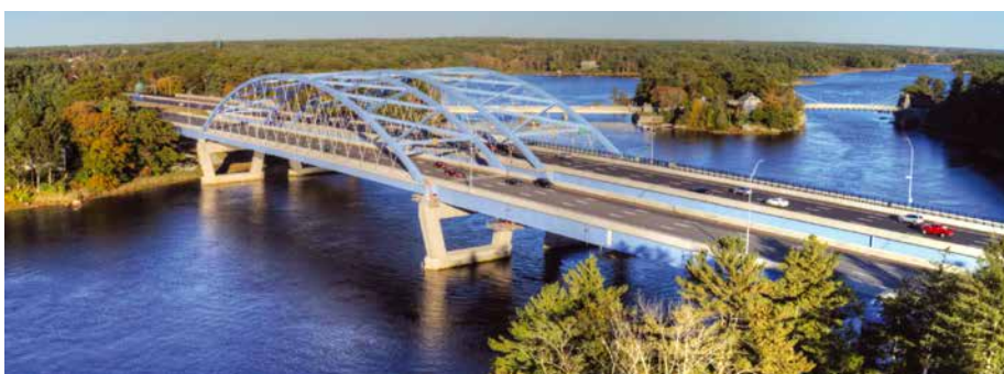
15. kép: John Greenleaf Whittier-híd, Massachusetts
