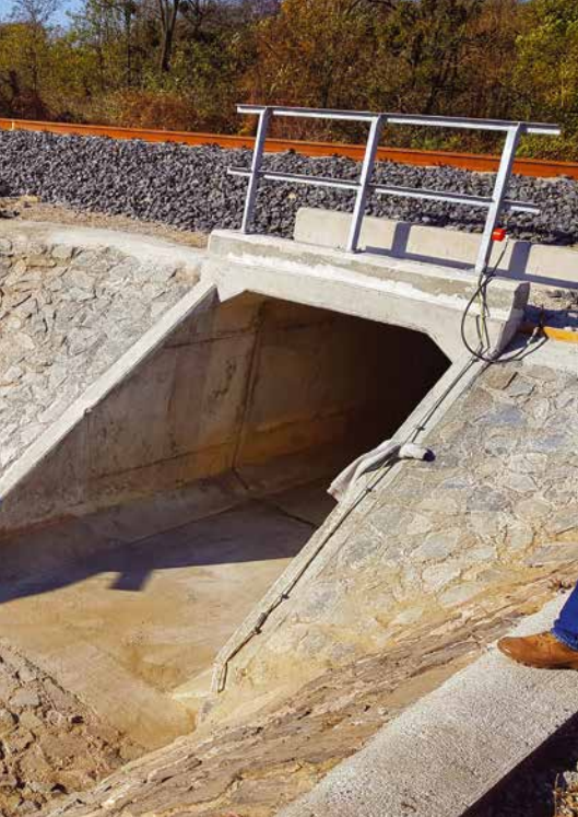
Ajka, Torna-patak II. híd végleges állapot
